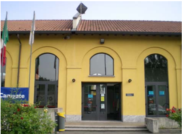
Fotografia n. 29 L'ingresso della biblioteca e dell'auditorium
