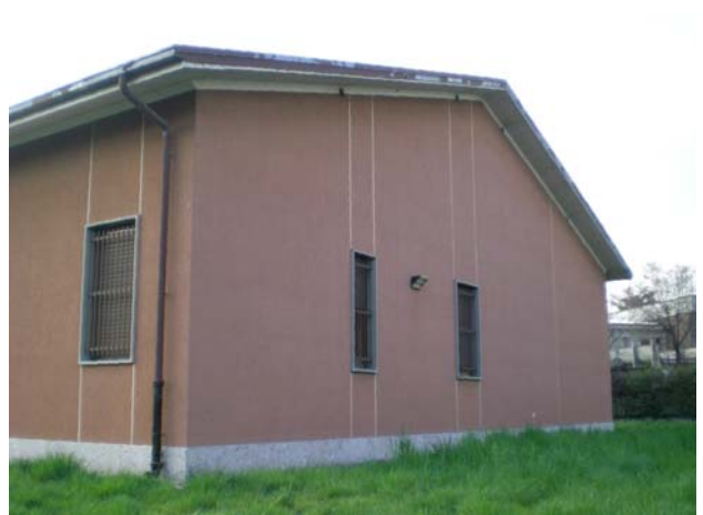
Fotografia n. 121 Centralina Telecom, via Dante Alighieri
