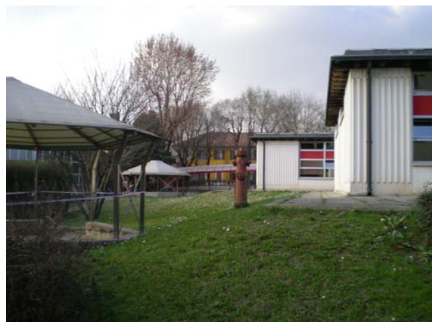
Fotografia n. 2 Scuola materna comunale, via D. Alighieri
