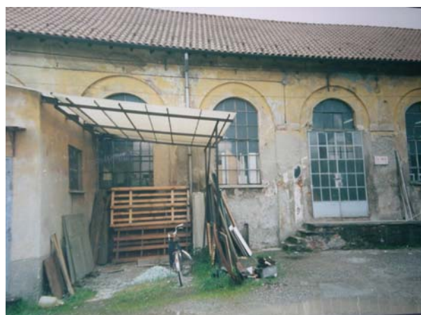
Fotografia n. 26 La vecchia filanda prima dei lavori di ristrutturazione
