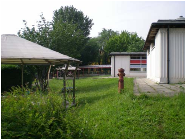
Fotografia n. 1 Scuola materna comunale, via D. Alighieri
