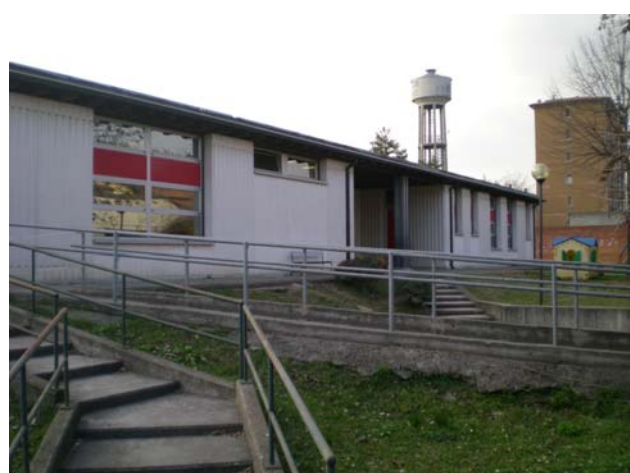
Fotografia n. 4 Scuola materna comunale, via D. Alighieri
