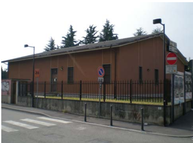
Fotografia n. 120 Centralina Telecom, via Dante Alighieri
