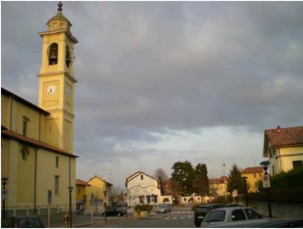
Fotografia n. 65 Chiesa parrocchiale di S. Zenone Vescovo: la facciata della chiesa, in piazza S. Zenone
