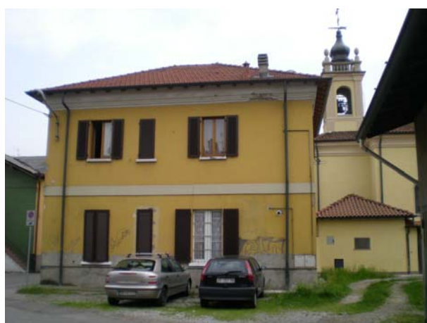
Fotografia n. 81 Edilizia residenziale sociale, frazione Torrazza, via Magellano
