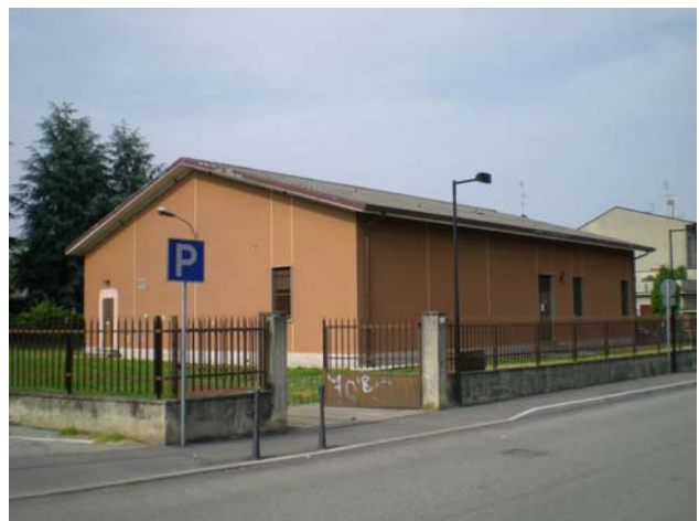
Fotografia n. 119 Centralina Telecom, via Dante Alighieri
