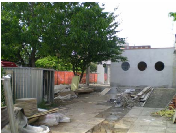
Fotografia n. 128 Asilo nido in progetto: il cantiere
