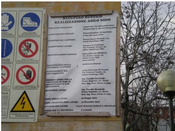
Fotografia n. 126 Asilo nido in progetto, via Dante Alighieri: insegna dei lavori in corso
