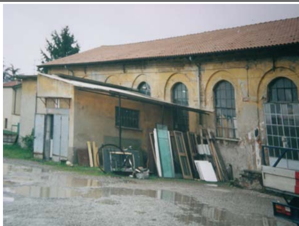
Fotografia n. 25 La vecchia filanda prima dei lavori di ristrutturazione
