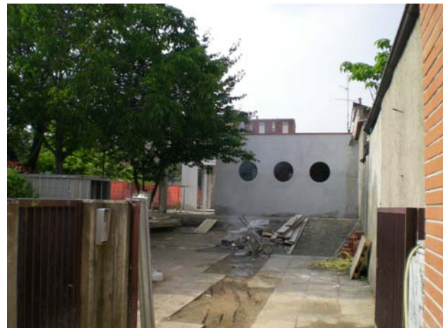
Fotografia n. 127 Asilo nido in progetto: il cantiere
