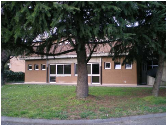
Fotografia n. 118 Centralina Telecom, via Dante Alighieri
