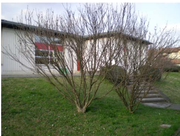
Fotografia n. 3 Scuola materna comunale, via D. Alighieri
